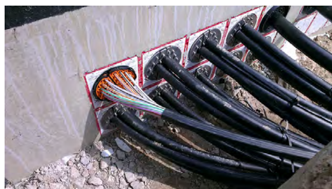
HSI150 – SEGMENTO – con control de par integrado y tapones ciegos
