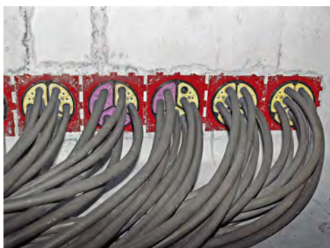
Sellado de cables para alumbrado público con SEGMENTO
